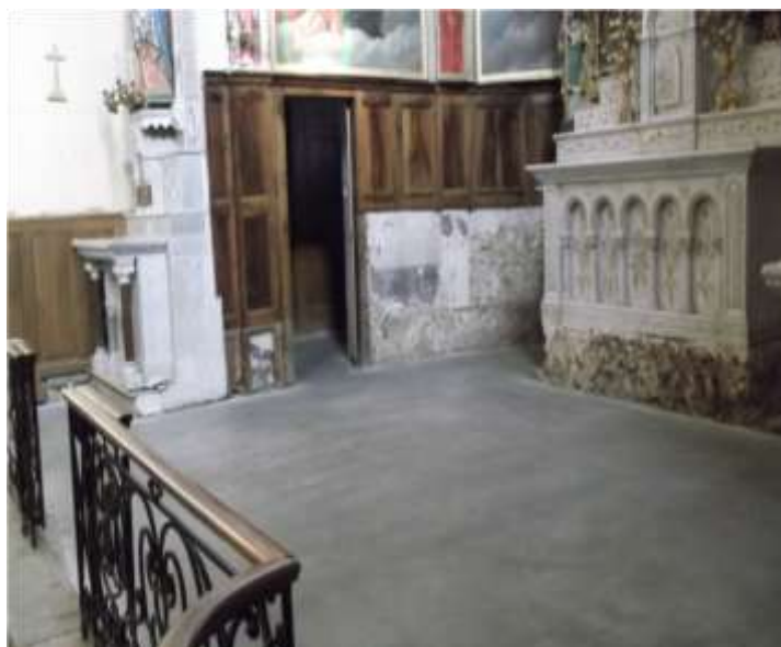
La dalle de béton lissée, dans le chœur et les sacristies
