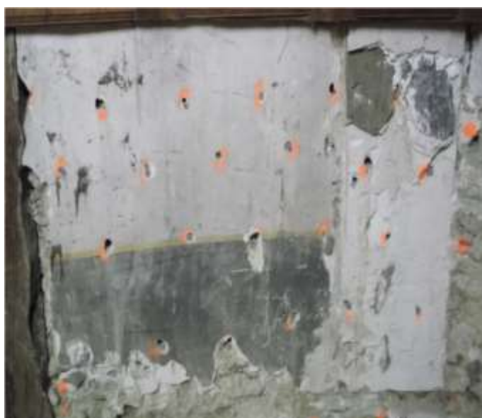
Après le traitement des murs du chœur
